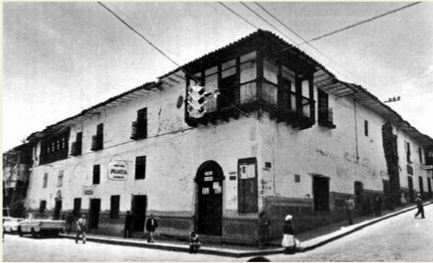
Antes de su intervención
