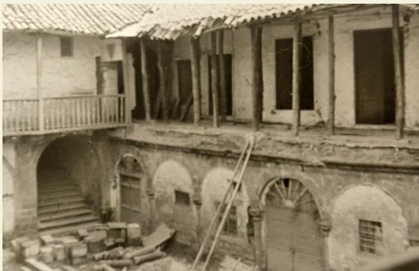
Antes de su intervención
