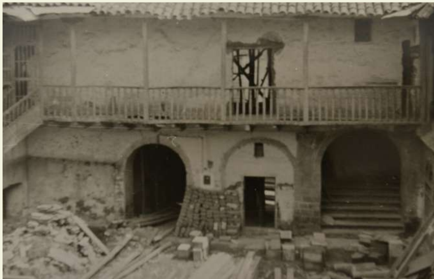
Antes de su intervención
