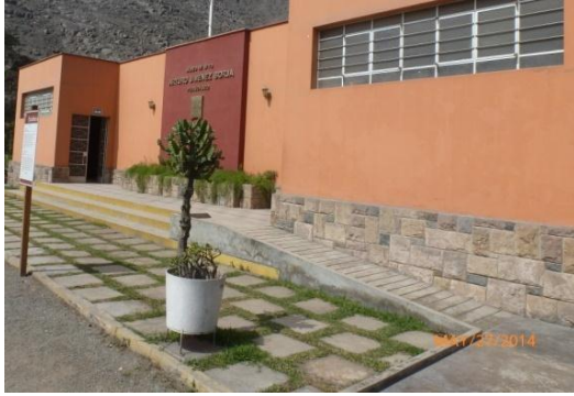
Figura 11 Rampa de acceso (Museo de Sitio Arturo Jiménez Borja+Puruchuco)
